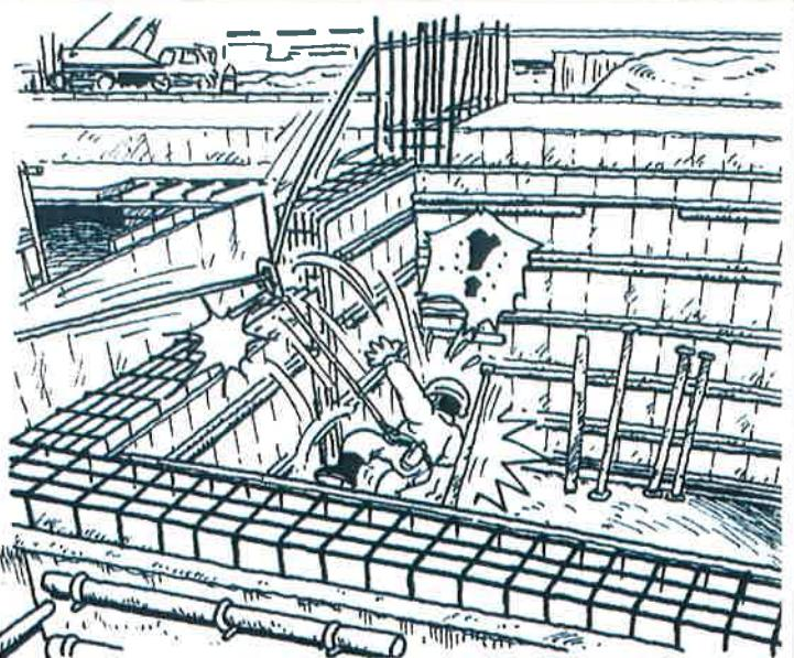
配筋写真を撮影するため、配筋済みの梁の天端を撮影用の道具を持ちながら、親綱に安全帯を使用しながら歩行中、足元を滑らせて、梁側面へ転落、安全帯の伸縮と体重の反動で、下部に設置してあった型枠の控えのサポートに右肩～首の部分が接触、及び足を接触させた。
